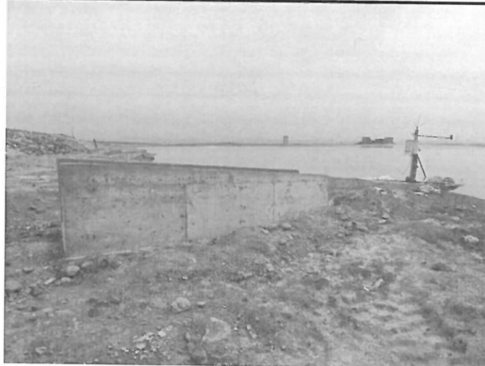
图 3.2.2.1-1 排洪系统排水斜槽外观
