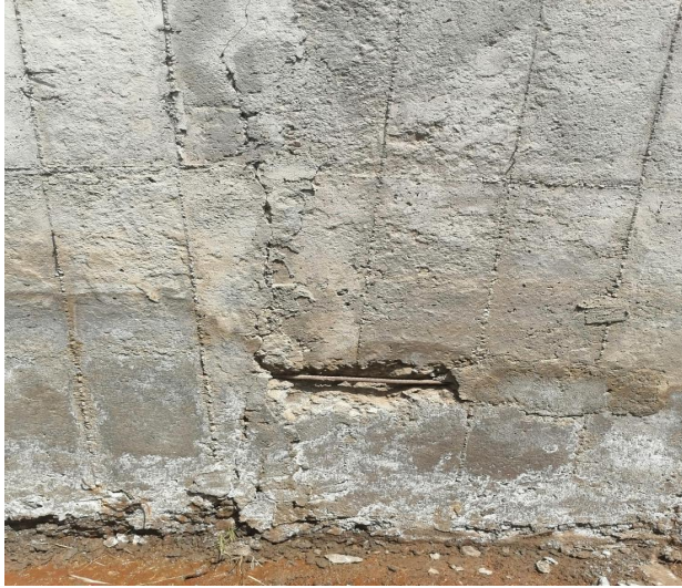
图 3.2.2.3-3 25 米处北边墙露筋
