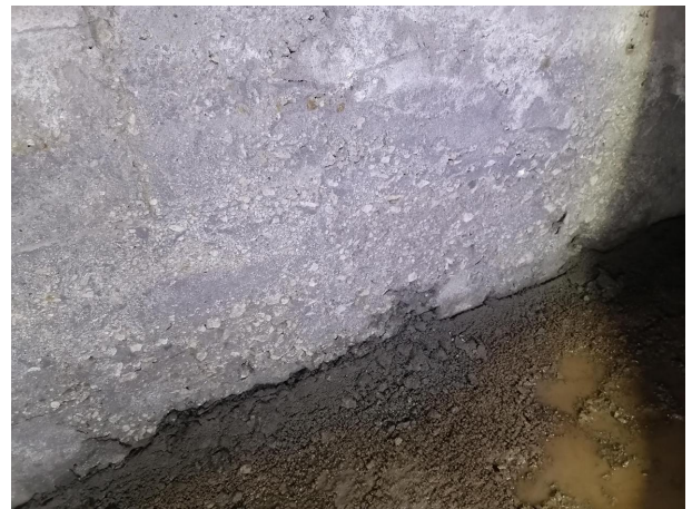
图 3.2.2.2-6 62 米处南边墙初喷混凝土脱落
