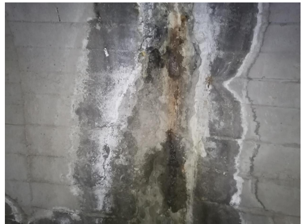
图 3.2.2.2-2 隧洞洞口南边墙混凝土脱落、露筋
