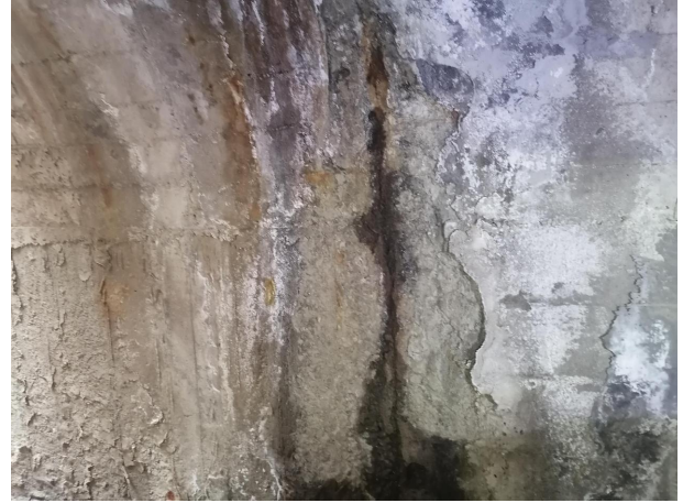
图 3.2.2.2-2 隧洞洞口南边墙混凝土脱落、露筋
