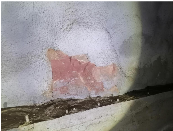
图 3.2.2.2-5 40 米处初喷混凝土脱落
