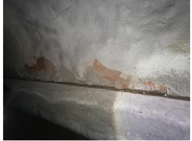
图 3.2.2.2-6 62 米处南边墙初喷混凝土脱落
