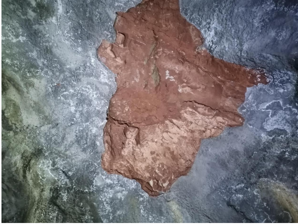
图 3.2.2.2-5 40 米处初喷混凝土脱落
