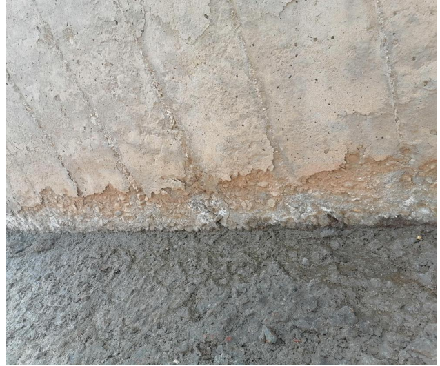
3.2.2.3-4 60 米处南边墙墙角混凝土脱落
