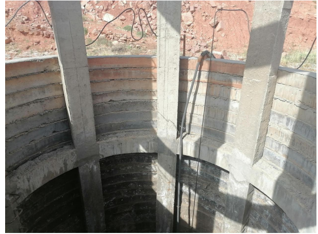
图 3.2.2.1-2 排洪系统溢水塔拱盖板
