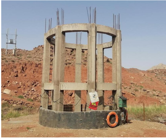
图 3.2.2.1-1 排洪系统溢水塔外观
